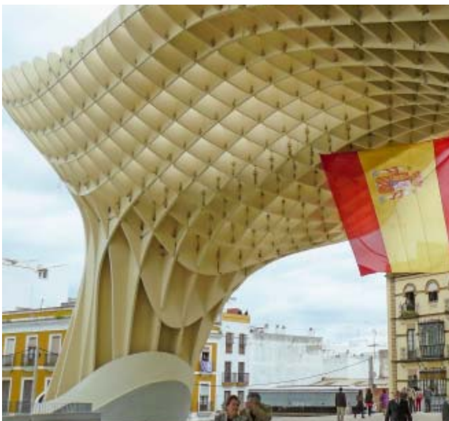
Die Konstruktion ist bis zu 28 m hoch und verschattet eine Fläche von rund 11 000 m 2 .
