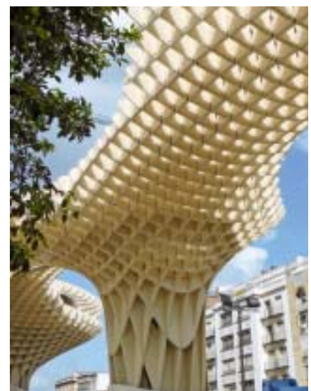
Die Konstruktion ist bis zu 28 m hoch und verschattet eine Fläche von rund 11 000 m 2 .
