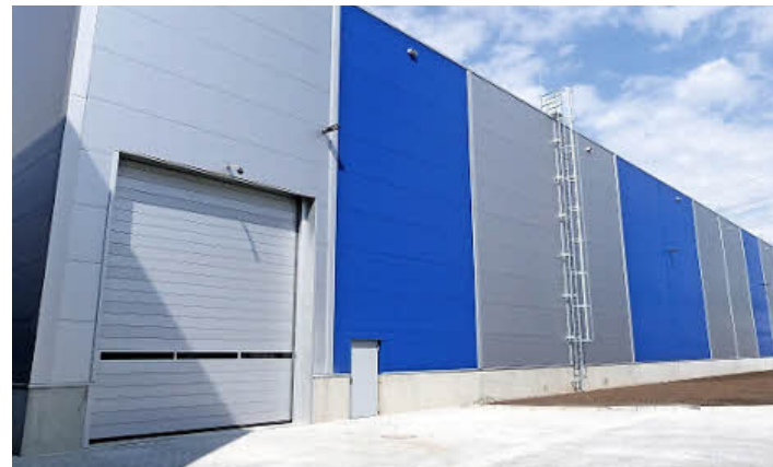
Binnen kürzester Zeit entstand im Industriegebiet „Am goldenen Feld“ diese riesige Lagerhalle der Firma BOT Oberflächentechnik GmbH. Fotos: Reißaus
